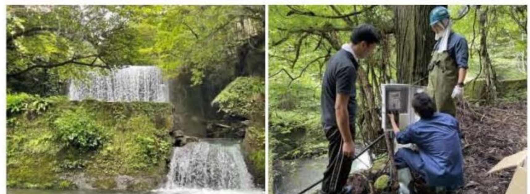
建設予定地での水量測定器設置
